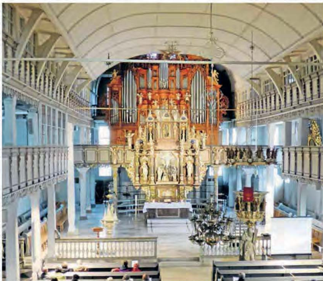
Meilenstein für die geplante Innensanierung der Clausthaler Marktkirche zum Heiligen Geist: Mit 2,61 Millionen Euro übernimmt der Bund die Hälfte der veranschlagten Kosten für die Innensanierung der größten Holzkirche Deutschlands. Foto: Ebeling
