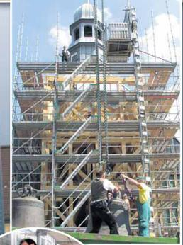
Die restaurierten Glocken kehren in den neu errichteten Turm zurück. Als im August 2008 zum ersten Mal nach fünf Jahren ihr Dreiklang ertönt, hören viele Clausthaler bewegt zu. Die Schwingungsmessung im Probelauren zeigt Ergebnisse im Zehntelmillimeterbereich. Präzisionsarbeit leisten auch die Zimmerer, die mit Kettenzügen das Oktagon in seine Lager rücken (oben), und zum Schluss die Maler (links) mit Leinölfarbe von der Grundierung über den Voranstrich bis zum blauen Endanstrich.
