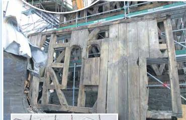
Der Blick ins Innere des alten Glockenturms zeigt den erschreckenden Zustand des Gebälks. Komplette rekonstruiert werden auch die acht völlig zerstörten Dachgauben (links). Schwierigster und zugleich spektakulärster Bauabschnitt ist allerdings der Wiederaufbau des Turms: In ganzen Segmenten vorgefertigt, wird der Fachwerkschiff von den Zimmerleuten direkt neben der Kirche zusammengesetzt (unten) und am Stück aufs Fundament gehoben. Das Oktagon und die „Laterne“ (rechte Seite unten) folgen.
