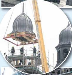
Der riesige Schwerlastkran aus Bad Harzburg ist in diesen Jahren öfter zu Gast in Clausthal: Hau- ab, Haube drauf: Präzisionsarbeit mit Tonnenlast an beiden Türmen.
