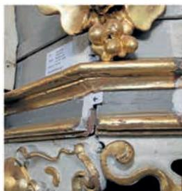
Pfeile markieren Suchfreilegungen an der Kanzel, die auf einem anderen Zettel genau dokumentiert sind.
